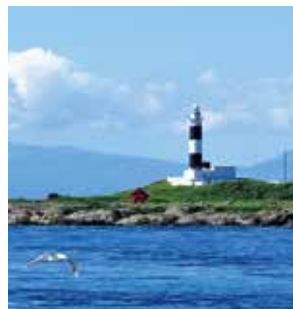
大間埼灯台(大間町・弁天島)
