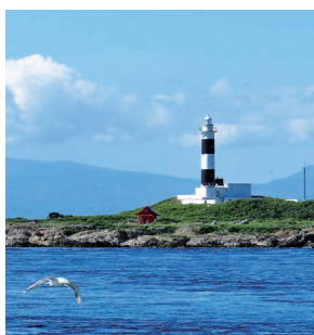
大間埼灯台(大間町・弁天島)
